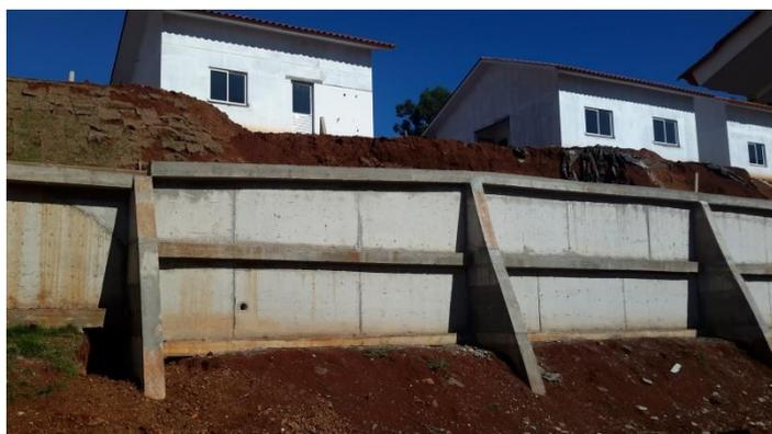
Figura 4: Intervenção em um talude de corte
