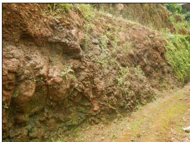
**Figura 16. Foto evidenciando a surgência d'água na parede do talude onde já ocorreu um pequeno deslizamento.**
