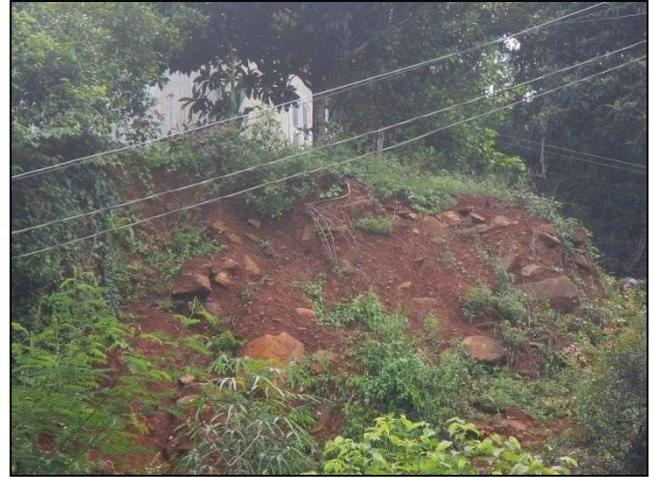
**Figura 10.** Casa no topo de um talude de aprox. 10m de altura. Observar fragilidade do material.
