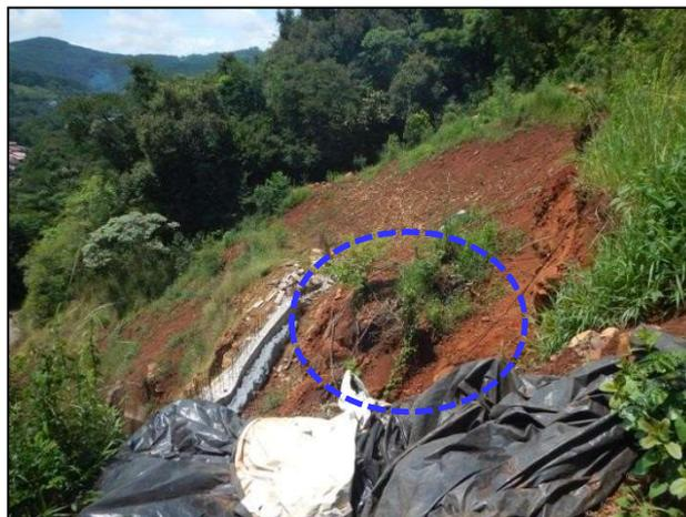
Figura 18. Ocorrência de movimentação de detritos. Observa-se tombamento de muro contenção feito sem nenhum critério técnico.
