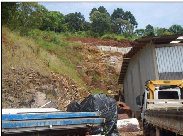
**Figura 13. Tornearia Mecânica. Intervenção com corte expressivo em rocha sã. Surgência d'água, queda de blocos e deslizamentos são constantes.**
