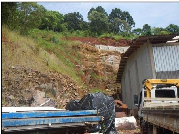
Figura 17. Construções no topo de talude de corte verticalizado em material de baixa competência, susceptível a deslizamentos.
