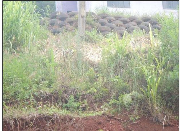
Figura 6. Observar a contenção com pneus, ineficiente, onde já ocorreu um pequeno deslizamento.
