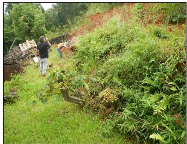
Figura 8. Aqui há um deslizamento recente (2017). A base do piso e a grama também se elevaram.
