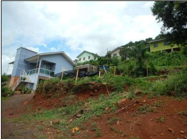
Figura 5. Talude de corte evidenciando material de baixa competência, susceptível a deslizamentos.
