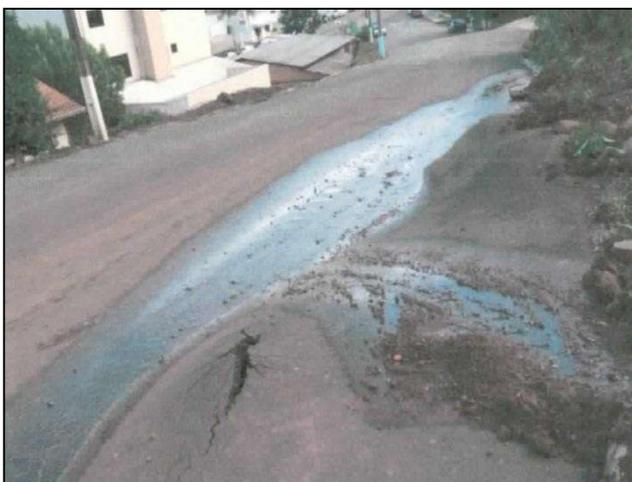
Figura 7. Foto presente no Parecer Técnico CEPED-UFSC - 2010. Observar o entumecimento do asfalto.
