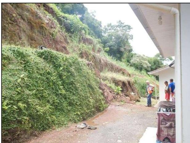
**Figura 15. Ocorrência de deslizamento de material de baixa competência em talude de corte verticalizado**
