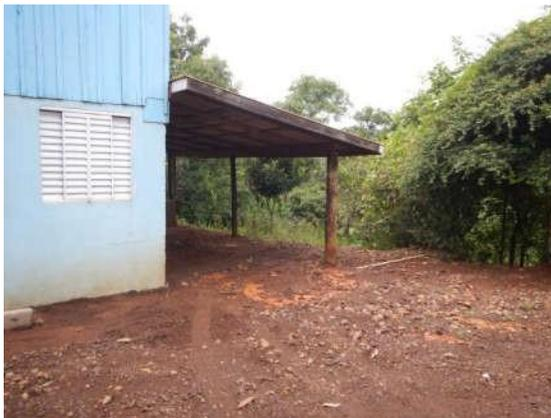
**Figura 9. Casa construída sobre aterro.**
