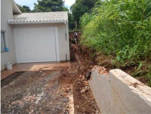
**Figura 7. Casa construída muito próxima à corte de talude íngreme em encosta.**
