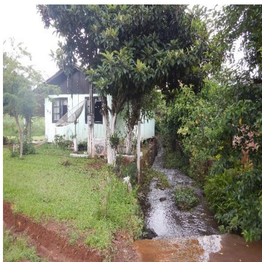
Figura 7. Casa com fundação na margem de córrego. Bairro Centro.
