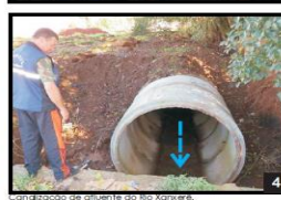
Canalização de afluentes do Rio Xanxerê.
