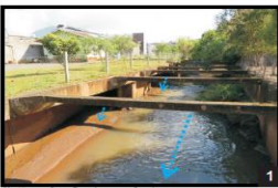
Rio Xanxerê e afluentes canalizados.
