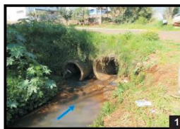
Canalização da drenagem.
