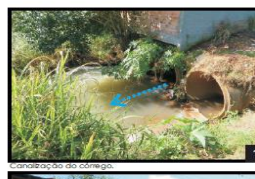
canalização do córrego.
