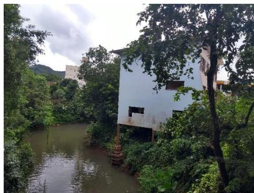
Figura 6. Residência localizada no setor SC\_LUZERNA\_SR\_02\_CPRM com pilares construídos dentro do rio.
