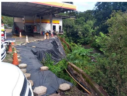
Figura 5. Solapamento de margem de riacho afluente do Rio do Peixe. SC\_LUZERNA\_SR\_02\_CPRM.
