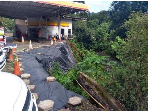
Figura 5. Solapamento de margem de riacho afluentado Rio do Peixe. SC\_LUZERNA\_SR\_02\_CPRM.
