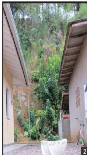
Residências muito próximas a taludes íngremes.
