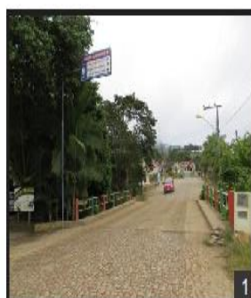
Ponte sobre Rio Dollmann no setor 02.
