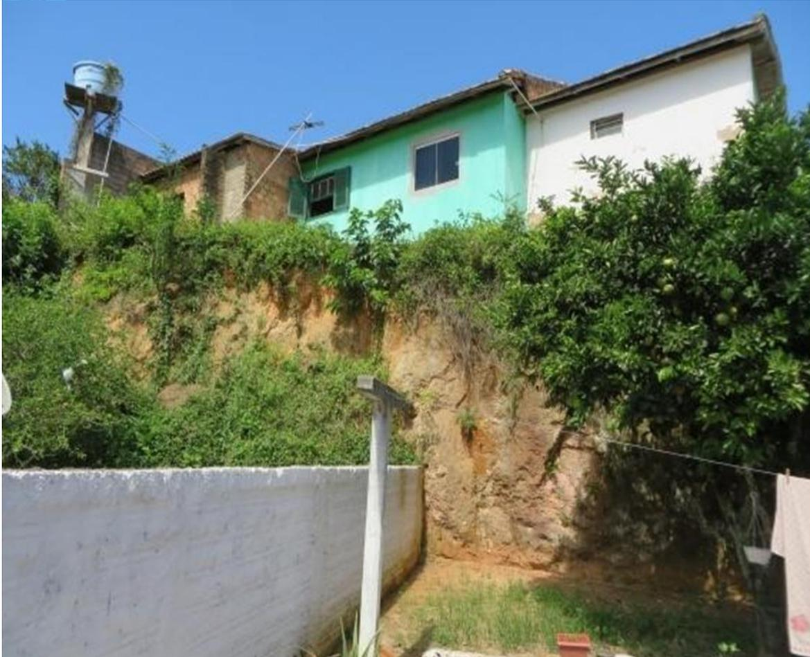
Figura 9. Residência na crista de talude de corte onde se observa trincas na casa e no solo, situado no setor 5.
