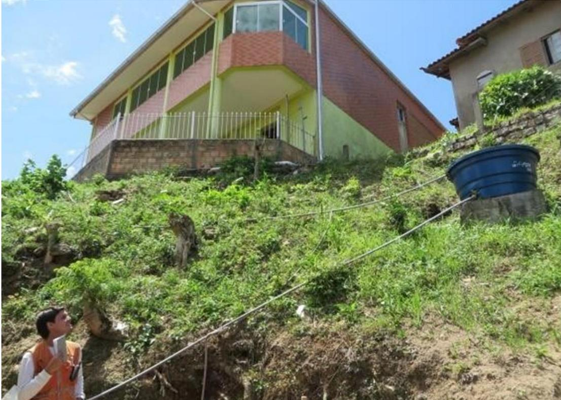
Figura 10. Setor de risco 9, no qual moradias estão situadas na crista e base de talude de corte íngreme, sujeitas a serem afetadas por deslizamentos.
