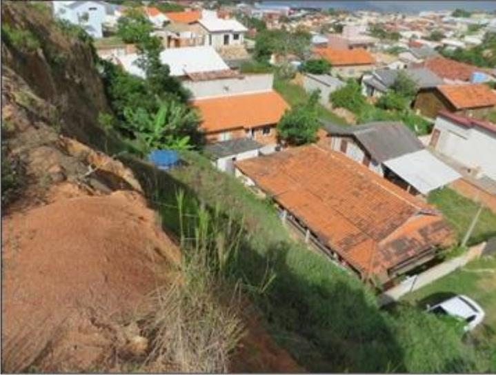
Figura 7. Casas próximas a talude de corte íngreme, com altura superior a 15 metros no setor 2.
