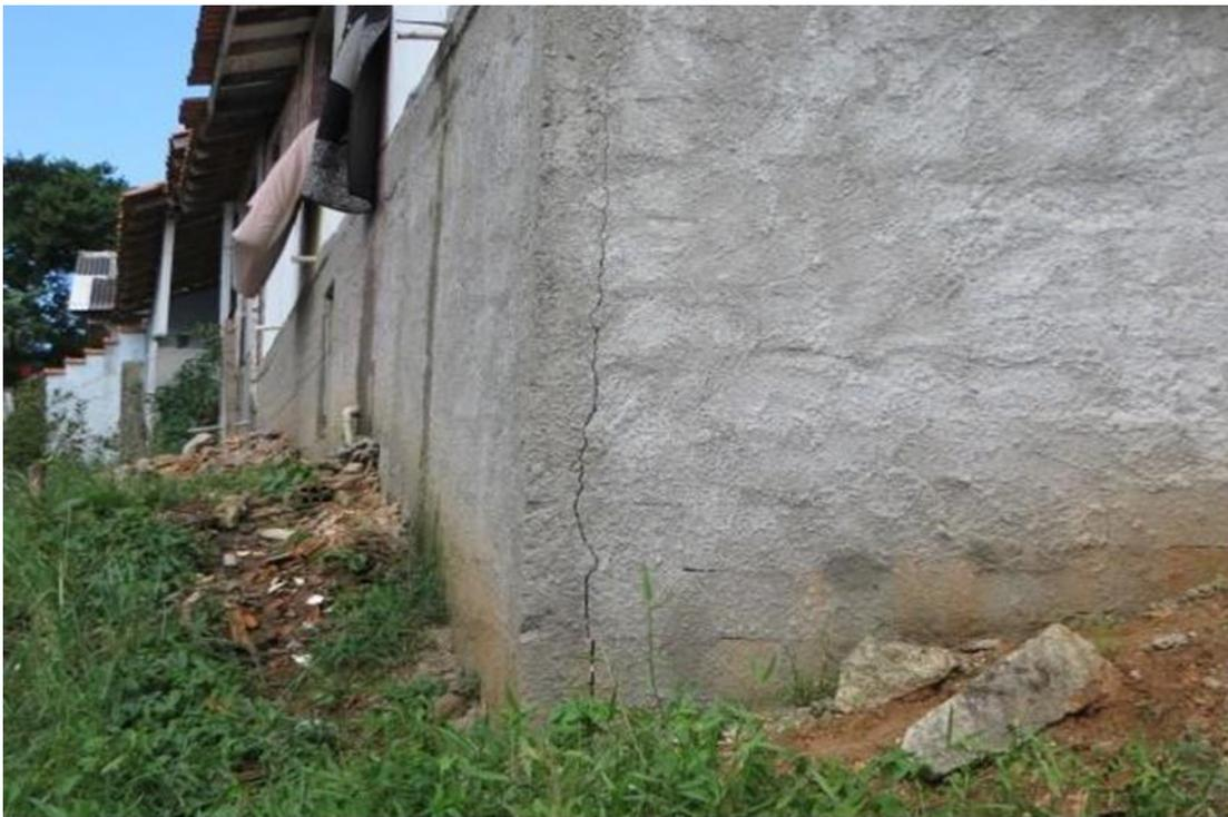
Figura 8. Trincas em moradia no setor 4, tendo sua estrutura afetada por movimentações do solo.
